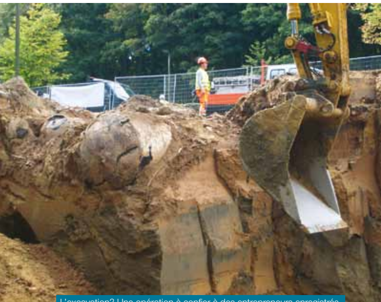
L'excavation? Une opération à confier à des entrepreneurs enregistrés.
