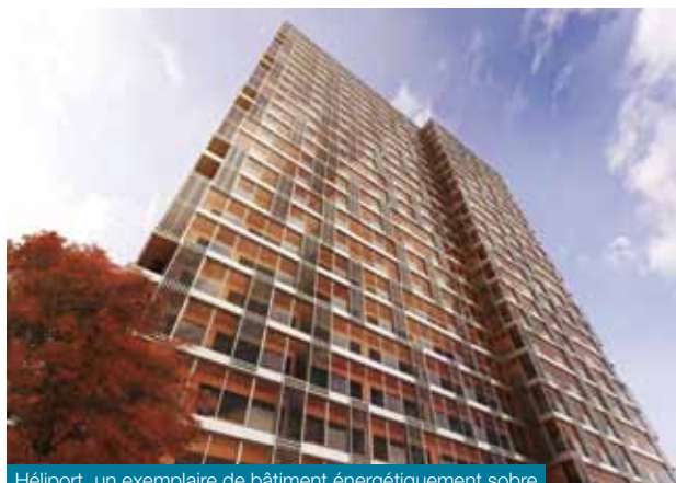
Héliport, un exemplaire de bâtiment énergétiquement sobre
